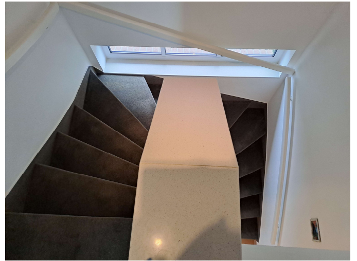
Treppe zum Dachgeschoss
